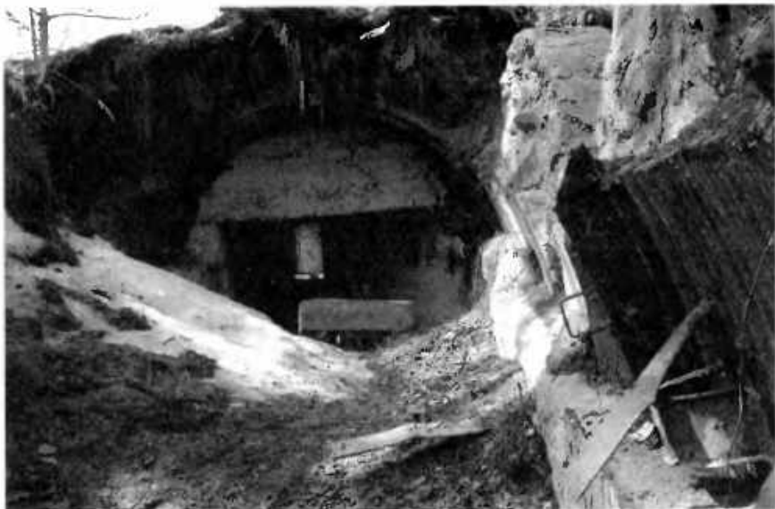
Фрагмент погреба 11-м батареи форта «Красная Горка», уничтоженного мародерами. Фотография В. Ф. Ткаченко. 2006 г.
